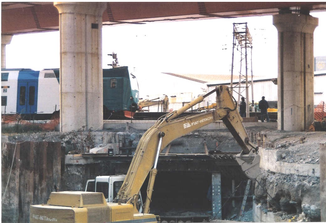
Il cantiere durante le ultime spinte; si noti quantità di elementi rasentati dal passaggio del monolite; la fondazione del portale t.e. è stata parzialmente sottopassata (per circa 80 cm)
