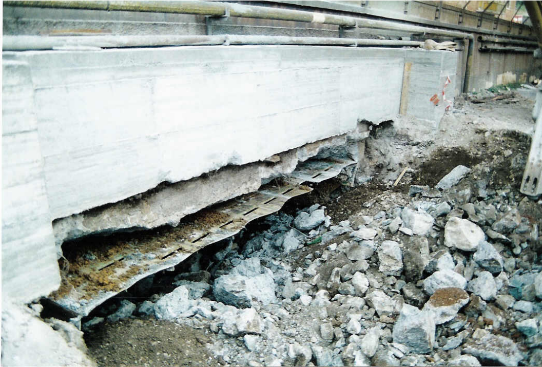
Affioramento dello scudo oltre la parete preventivamente rinforzata del terrapieno RFI
