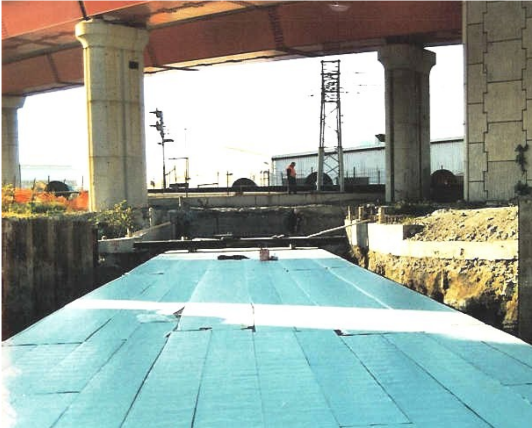
Contesto dell'opera e preparazione della superficie
