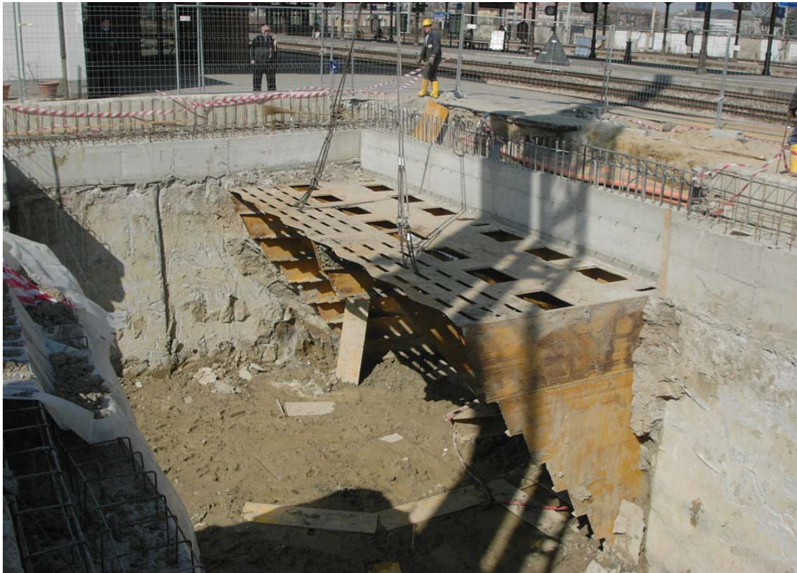
Smontaggio dello scudo
