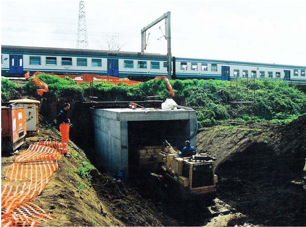
Transito di un treno con il cantiere in attività durante le ultime spinte; si noti la posizione del portale t.e.
